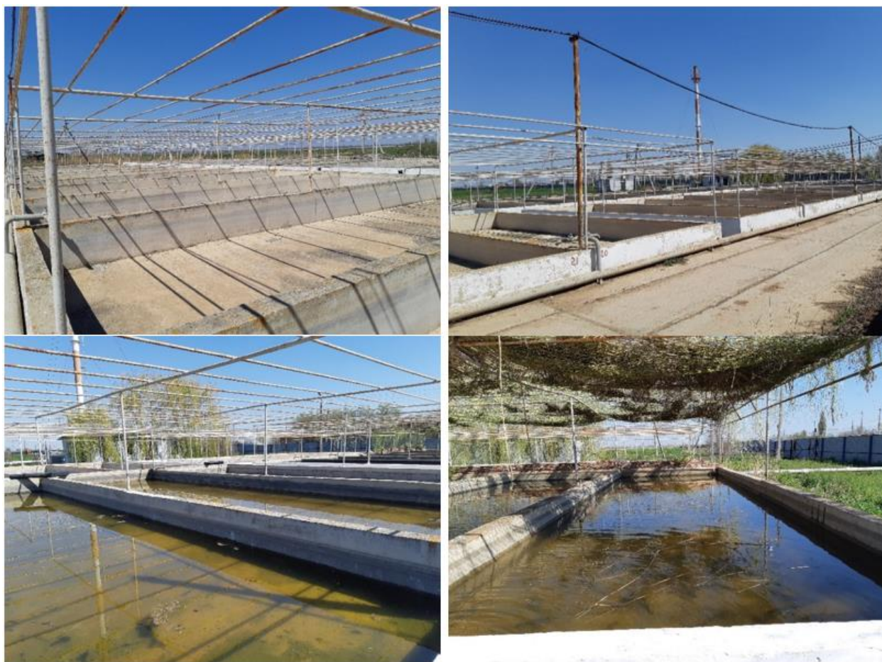
1-rasm. Beton xovuzlar
